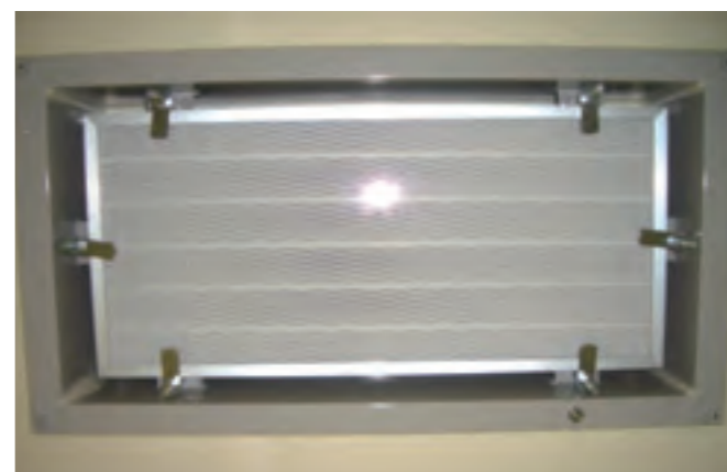
フィルタ設置
